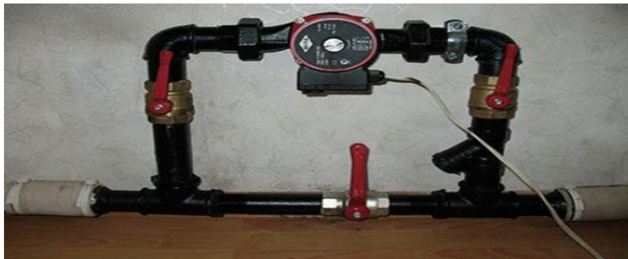
2.9-сурет – Жылыту айналма желісіндегі айналым сорғының жалпы көрінісі
