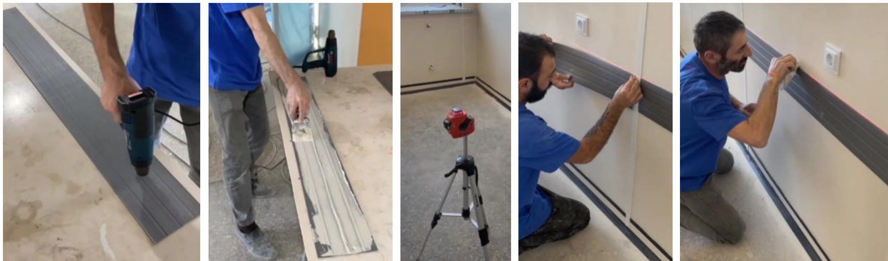
2.4-сурет – Қабырғаға орнатылған ПВХ қалқан тақтасын орнату процесі
