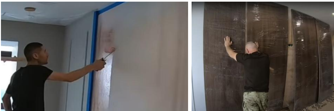
2.1-сурет – Ролик арқылы негізге праймерді жағу және панельдерді сынау
